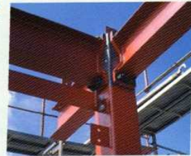
ハブプレート工法
